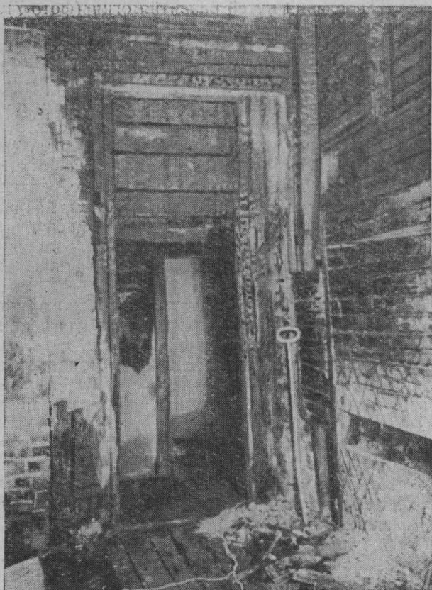
Фото 7. Характер обгорания деревянных конструкций указывает на то, что огонь распространился от пола к потолку.
