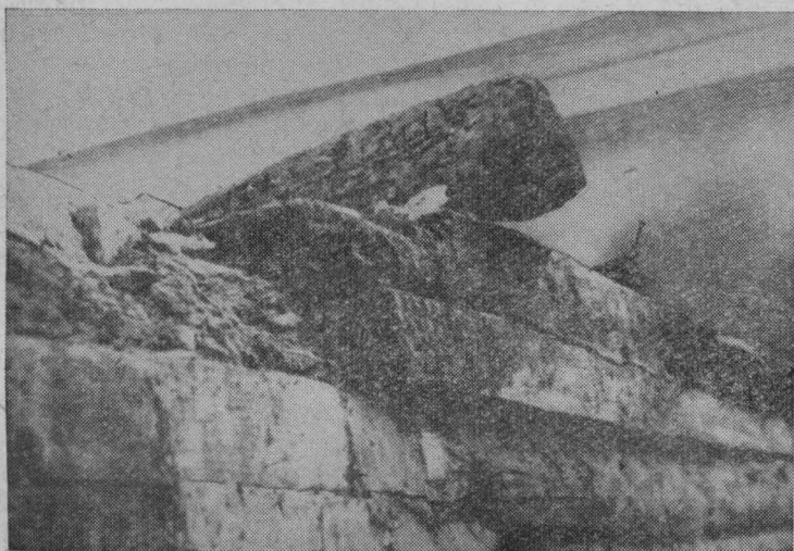
Фото 30. Деревянные балки, заделанные в дымоход. Под воздействием высокой температуры дерево обуглилось, а затем самовоспламенилось.
