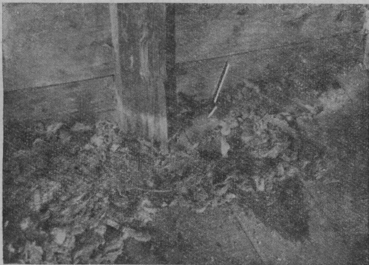
Фото 27. Местонахождение остатков стеарина сгоревшей свечи в помещении ларька показывает, что свеча не могла быть использована в целях освещения, а предназначалась для поджога.
