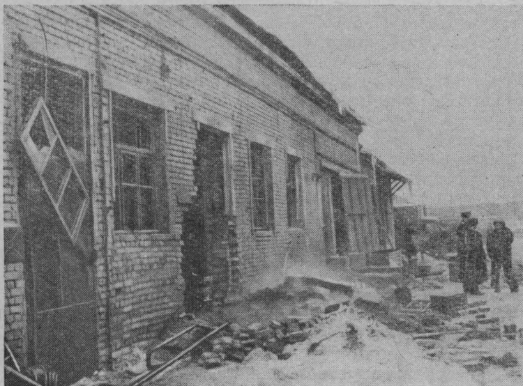
Фото 25. Фасад здания котельной с проломом, образовавшимся при вылете котла из котельной.
