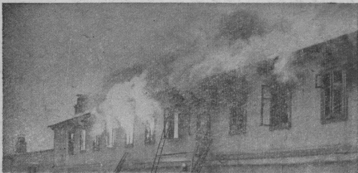
Фото 1. Сильное пламя и задымление указывают место, где происходит наиболее интенсивное горение (очаг пожара).
