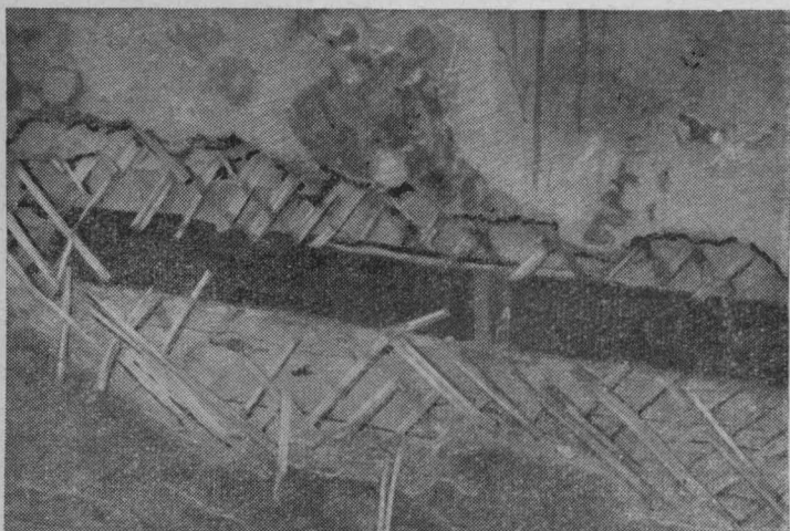
Фото 8. Пустотелая конструкция стены, способствовавшая распространению огня.
