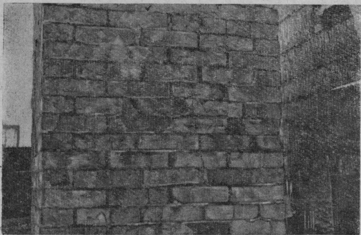
Фото 15. Кирпичная труба с трещинами и щелями, через которые пробивались искры и горячий воздух.
